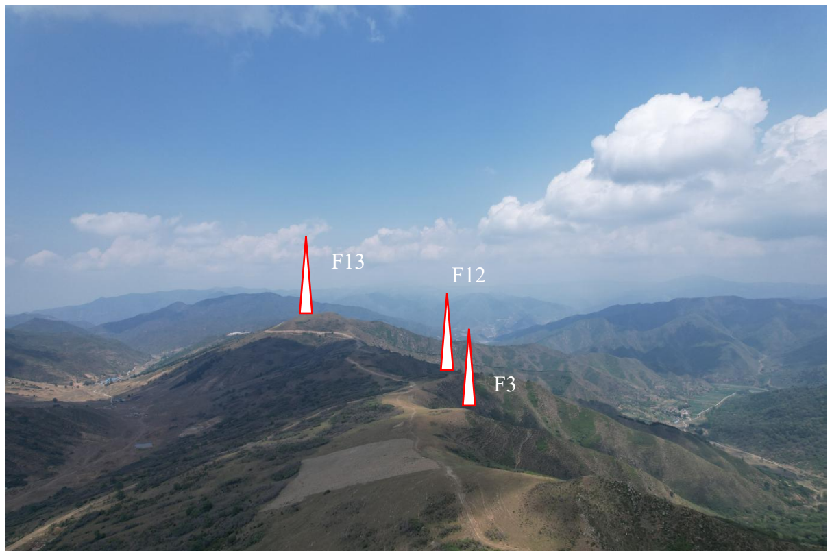
风场情况及改造道路
