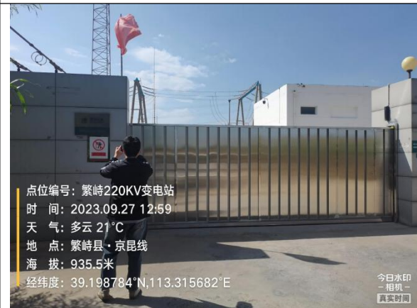
繁峙 220kV 升压站
