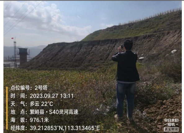
2号塔占地现状
